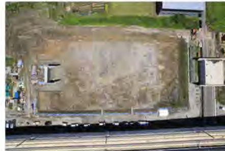
上層完掘状況 (上空から)
