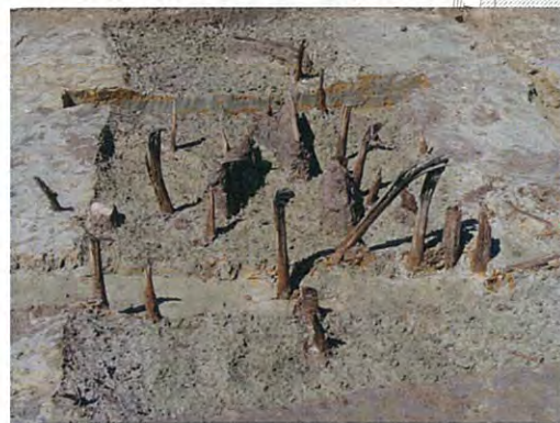
水路に打たれた杭
