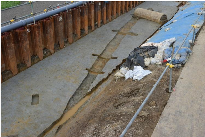
溝の完掘状況（26SD17）（南西から）
