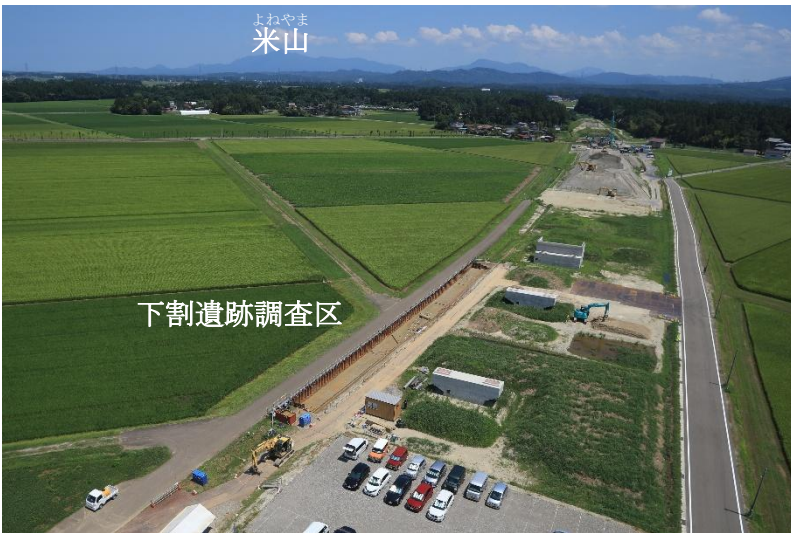
調査区全景（上空南西から）
