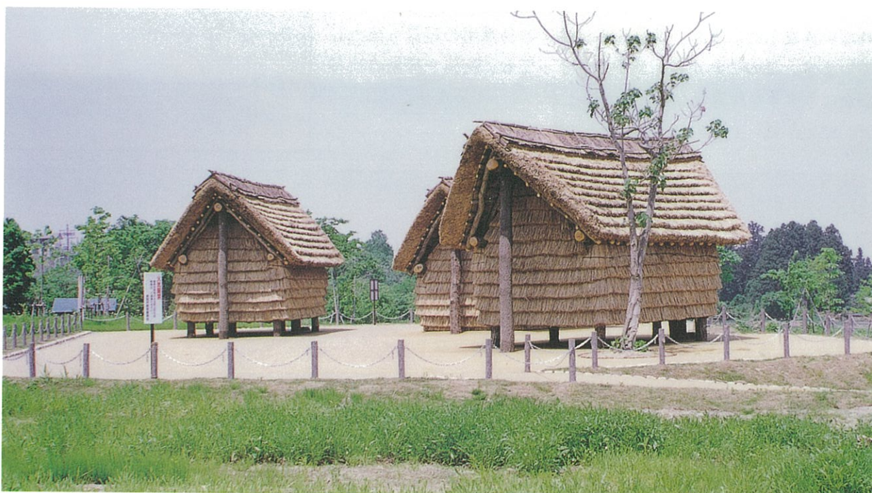
復元された掘立柱建物
