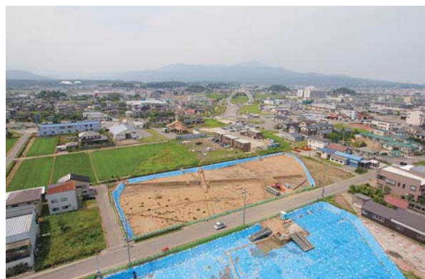
7区全景(北から、正面奥が米山)
