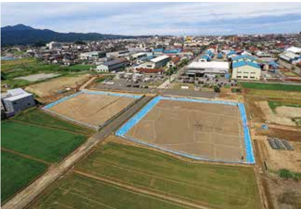
調査区全景 (上空北東から)
